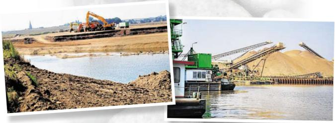
Zunächst wird die Lehmschicht abgegraben, dann der Kies darunter entnommen, anschließend kommt der Lehm wieder drauf. Das Wasser der Maas sucht sich dann selbst seinen Weg. Oben rechts: Der Kies wird in einem eigens für das Grenzmaas-Projekt angelegten Hafenbecken verarbeitet und dann über den mit dem Becken verbundenen Julianakanal verschifft.
