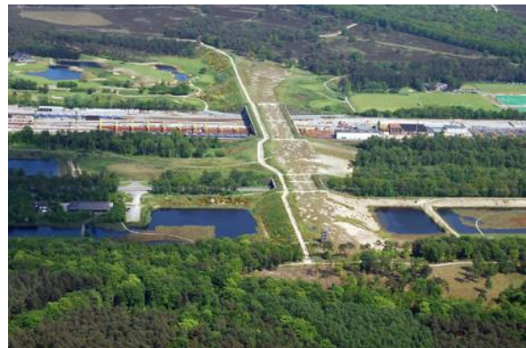
Figuur 1.4. Natuurbrug Zanderij Crailoo in 't Gooi, met 800m het langste ecoduct ter wereld. Het bevat 2 overspanningen van 50m breedte en heeft ook een afgeschermd wandel-, fiets- en ruiterspad (wageningenur.nl)
