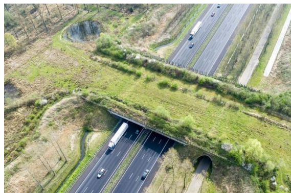
Figuur 4.1. Natuurbrug Het Groene Woud over de A2 bij Best. Dit ecoduct, gebouwd in 2005, heeft aan beide zijden over de lengte een greppel lopen. Deze monden op de uiteinden van het ecoduct uit in poelen (wegenwiki.nl)
