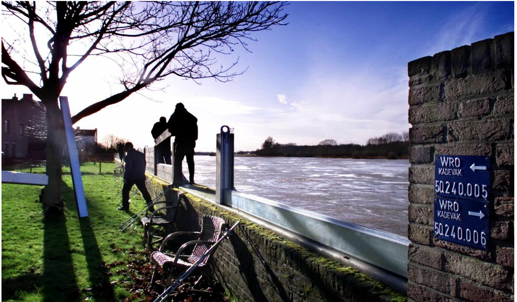
Maatregelen in de vorm van schotten tegen hoogwater bij Itteren in 2003.
