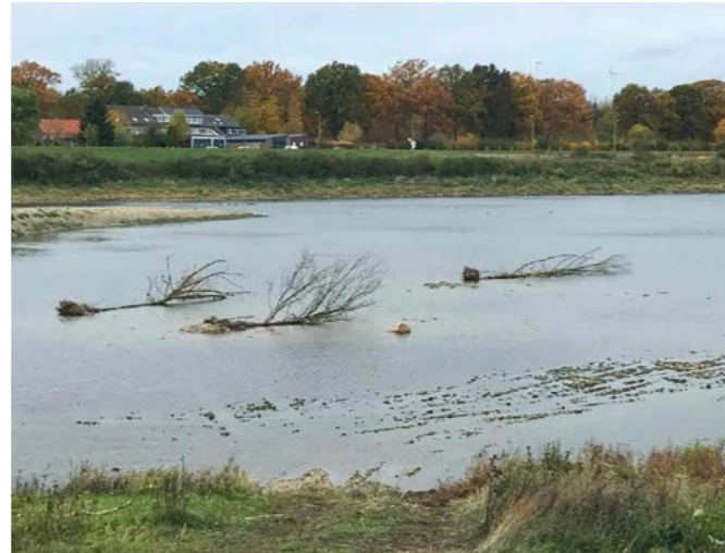
Rijkswaterstaat heeft ter hoogte van Borgharen bomen in de bedding aangebracht.
