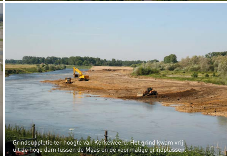
Herinrichting van Kerkeweerd en grindplas Negenoord rond 2010, waarbij de oevers zijn verlaagd en ontsteend en de voormalige plas in tweeën is gesplitst.
